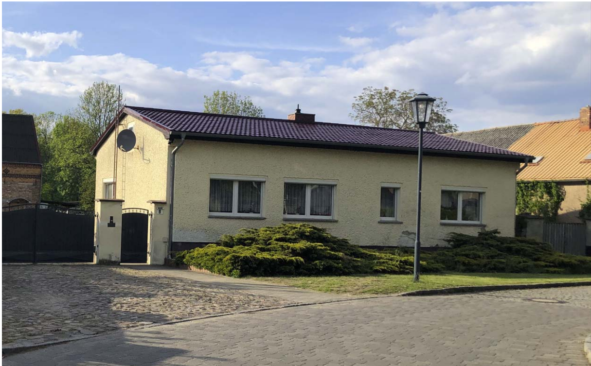
Abbildung 15: Wohnhaus Bauernreihe 8 mit abweichender Dachneigung
