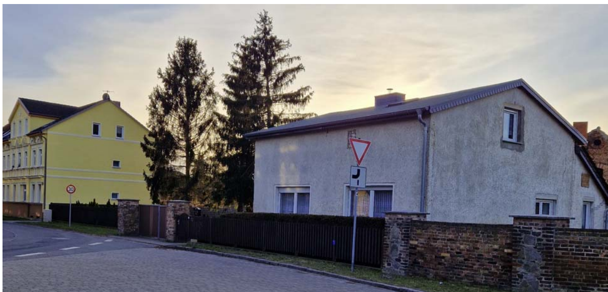
Abbildung 14: Wohnhaus Freiherr-von-Loeben-Straße 13 mit abweichender Einfriedung
