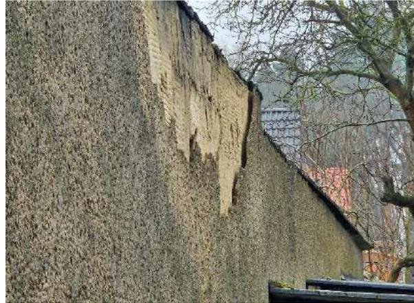
**Abbildung 25: Abplatzender Putz an Rückseite der Garagen**
