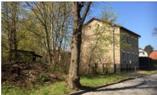
Abb. 7: Blick auf die nördliche Nachbarbebauung
