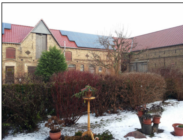
Hoflage Flurstück 306/2: nördliches Seitengebäude und hintere Scheune
